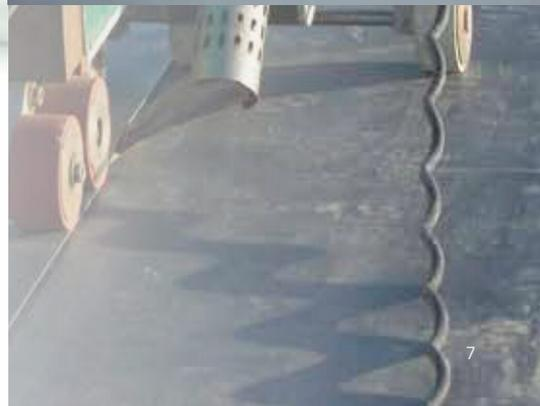
Étanchéité monocouche PVC-P fixée mécaniquement
